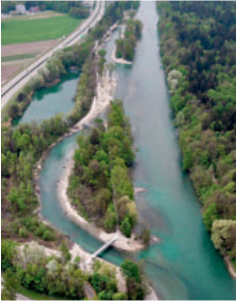
Renaturierung der Hunzigenau bei Rubigen (BE). Die Aufweitung des Aarebetts dient dem Hochwasser- und dem Naturschutz gleichermassen.
